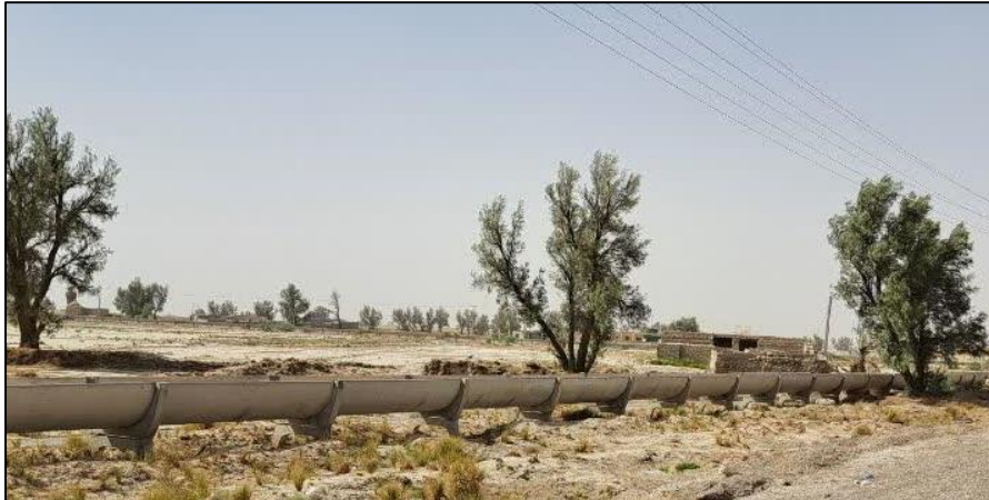
شکل ۸. طرح نیم لوله‌های آبیاری در سیستان که به‌جای آب، ماسه‌بادی انباشته است.
